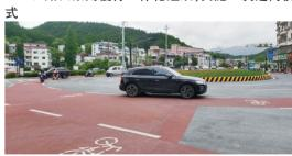
环岛非机动车通行空间全部采用醒目的红色 防滑标线铺装,一方面增加非机动车道吸引力,引 导非机动车规范通行,另一方面,红色给进出环岛 车辆以警示作用,起到主动预警的双重作用。
