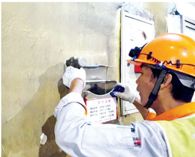
工作人员在安装消防收纳盒
