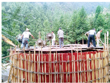
芹阳办事处丰源村饮用水安全提升工程
