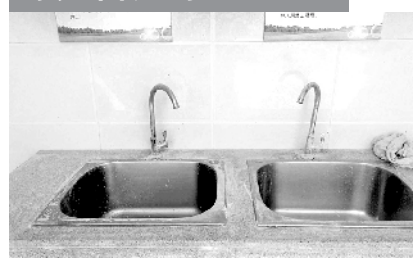
杨林镇新源村新区公厕内洗手盆已经更换。
