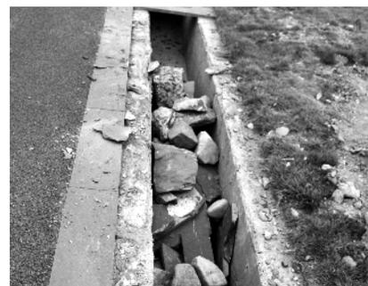
百里黄金水岸线华埠镇下溪段绿道排水沟青石板多处损坏。
