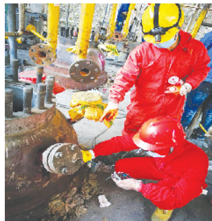
压力容器现场检验
