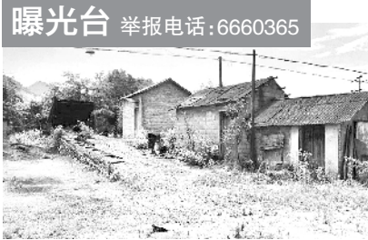
曝光台 举报电话:6660365 音坑乡华联村友旺砌块砖厂有五幢占地面积约 528 平方米的违法建筑,3000 余平方米水泥硬化地面。
