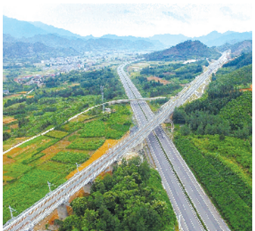
九景衢铁路与杭新景高速交汇
