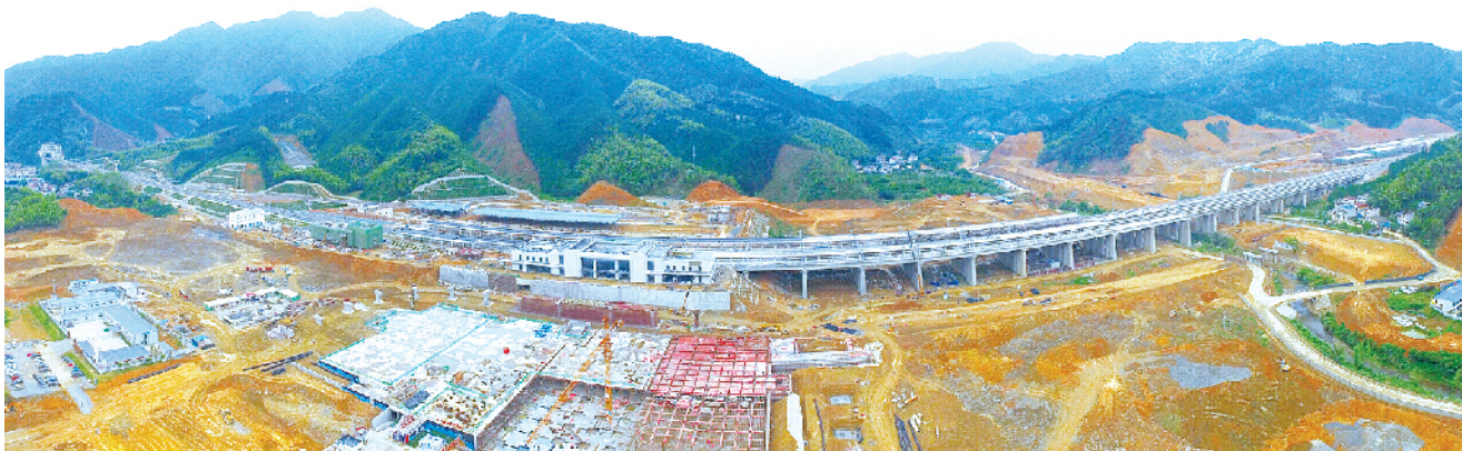
九景衢铁路开化火车站施工现场
